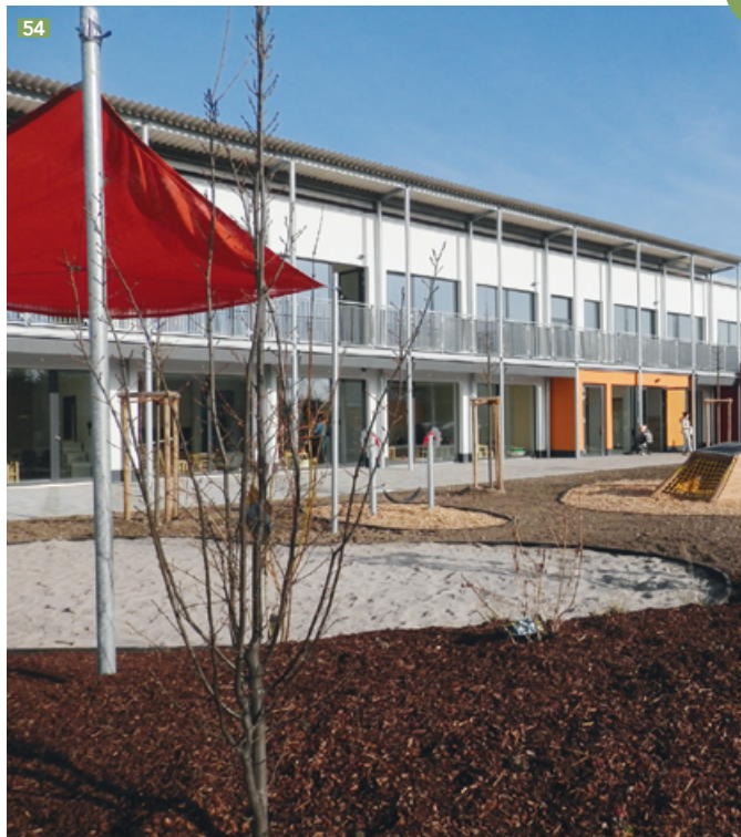
Städtische Kindertagesstätte „Landwirtschaftsschule“ in Passivhausbauweise in Frankenthal
